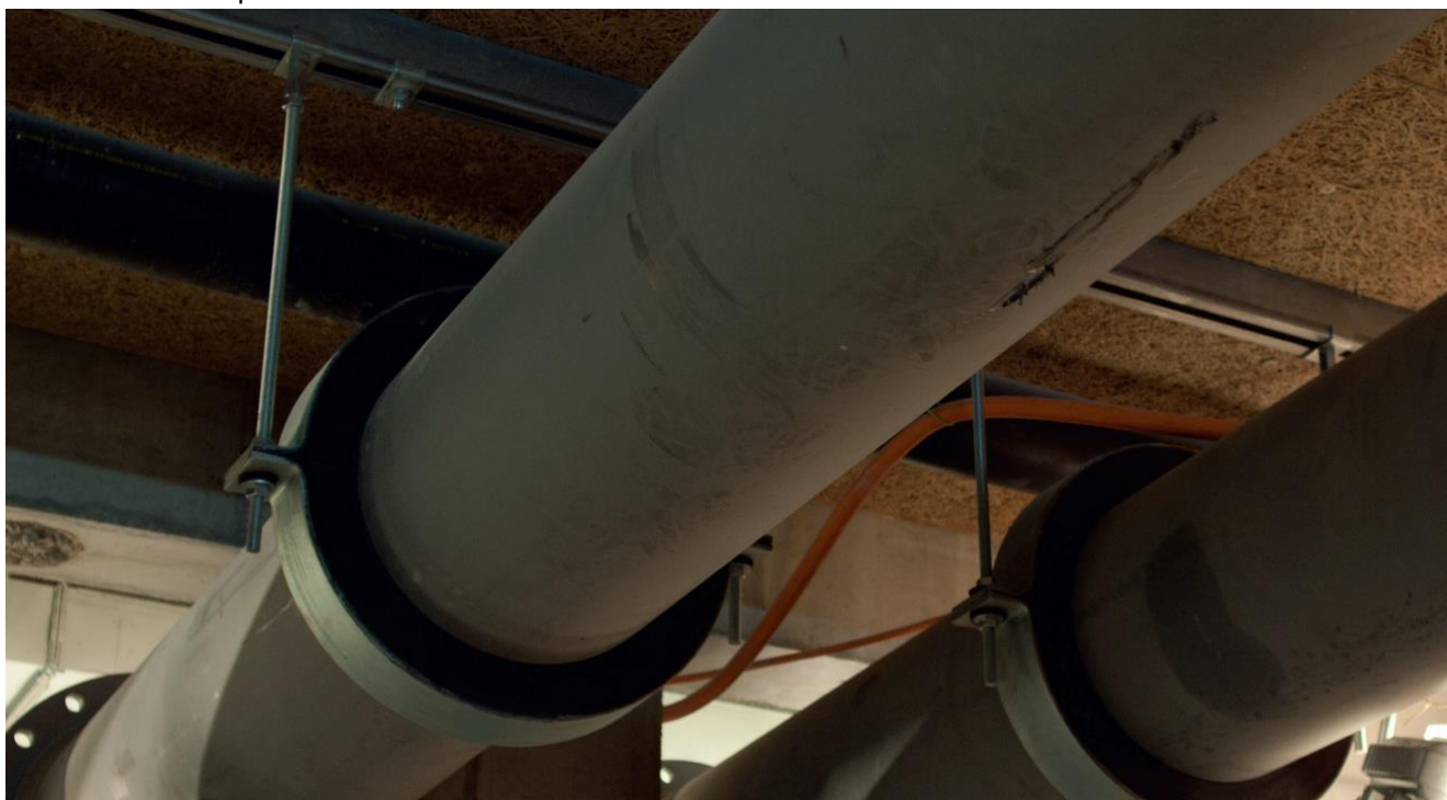
Figure 61 : Exemple image de fixation sanitaire
