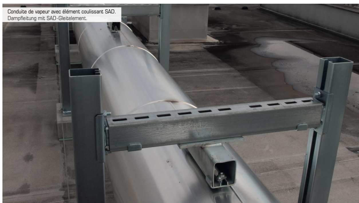
Figure 32 : Exemple image de fixation vapeur
