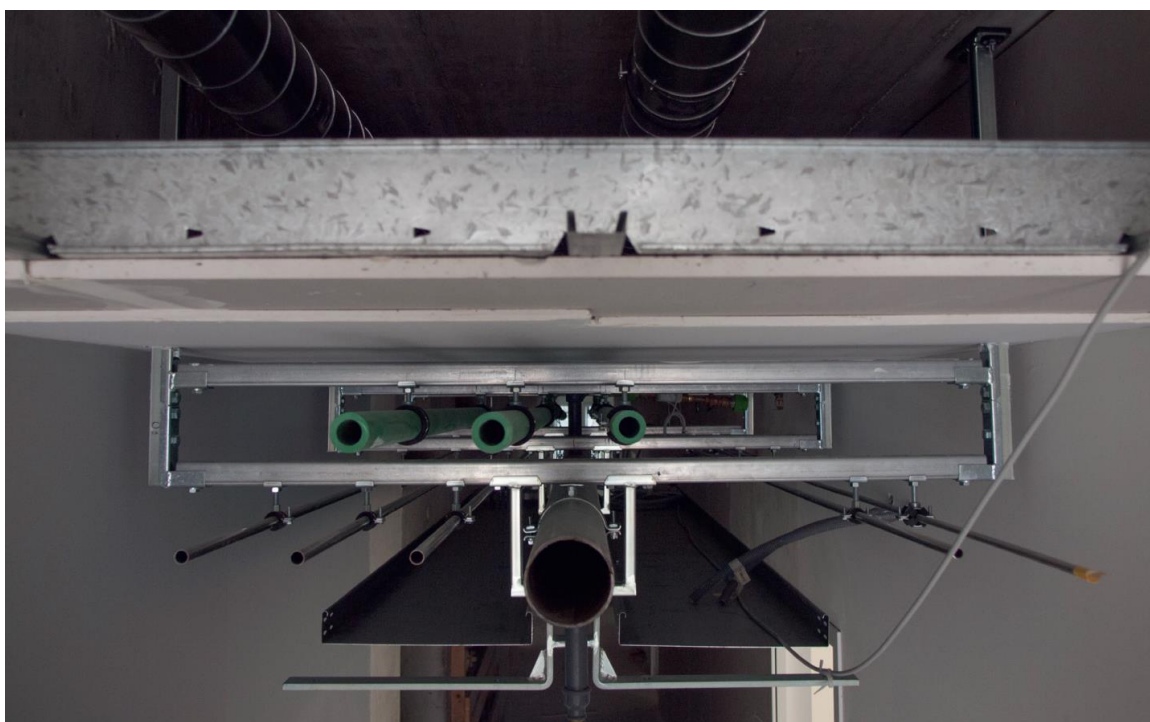
Figure 69 : Type de profil Samvaz pour chauffage
