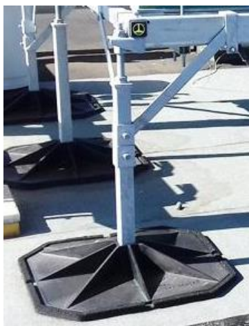
Figure 111 : Support pour installation technique de type BIGFOOT
