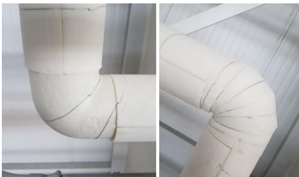
Figure 98 : Isolation préfabriqué en mousse Figure 99 : Isolation au moyen de segments de demi-coques en PIR
