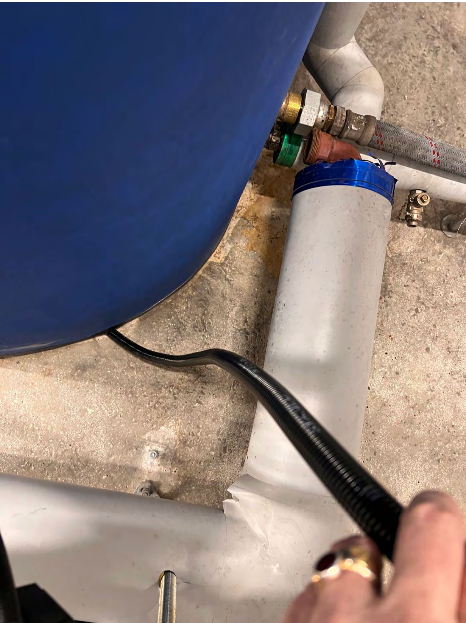
Mise à la terre du chauffe-eau à débrancher sur l'ancien et rebrancher sur le nouveau
