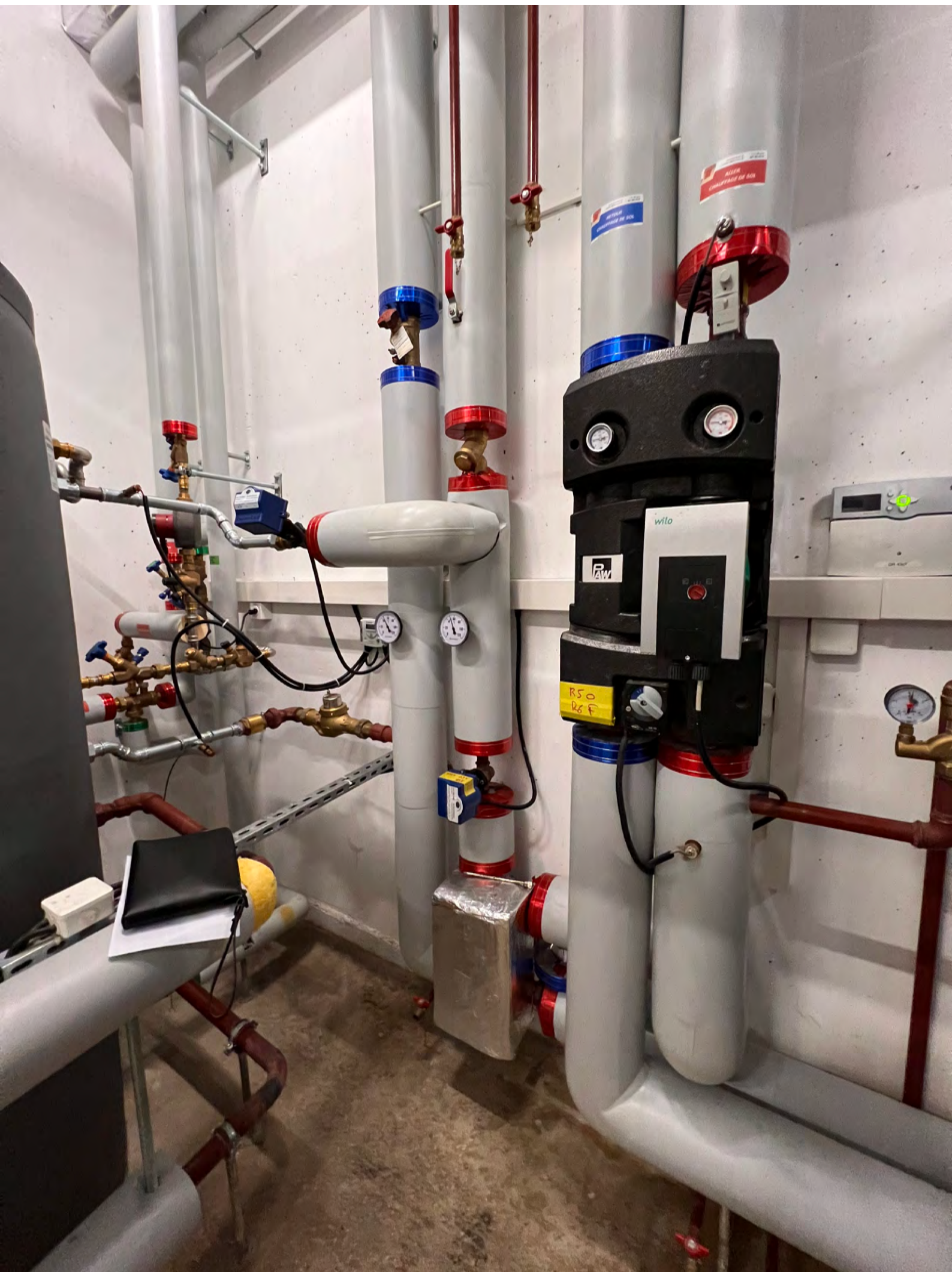
Exemple du principe des raccordements du chauffe-eau
