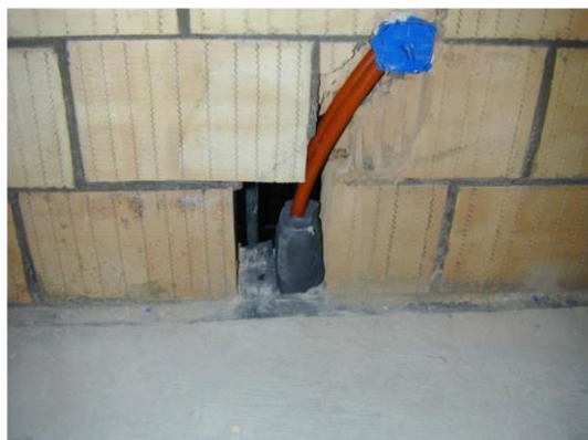
Figure 8 : Isolation passage des conduits
